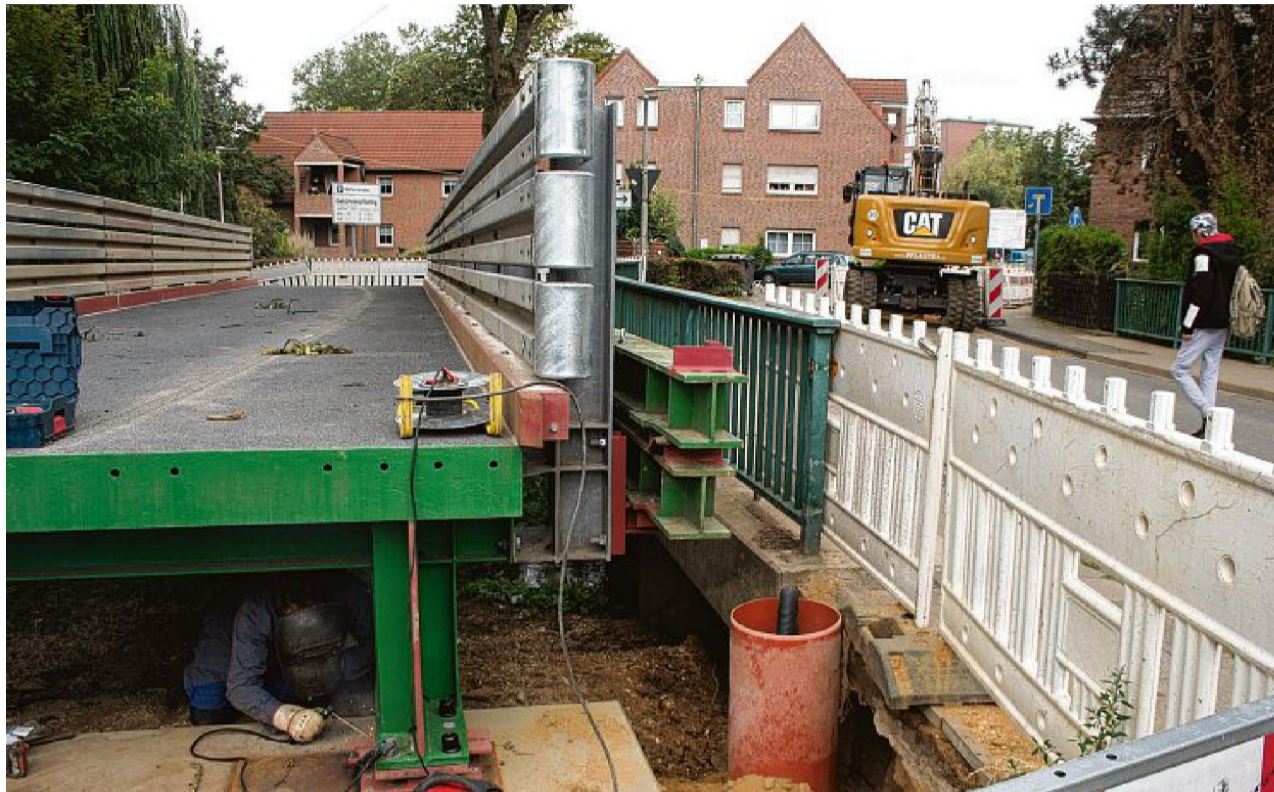
Die Behelfsbrücke über die kleine Erft wird auf ihren Einsatz vorbereitet.
